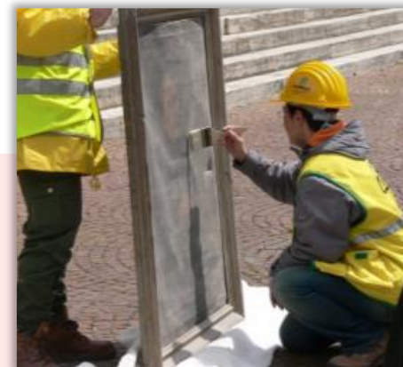
Messa in sicurezza - Opere di preconsolidamento
